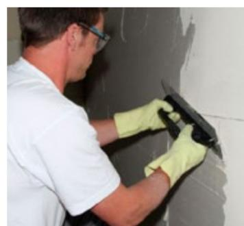
Após a instalação das placas, a superfície deve ser lixada. Subsequentemente, a área inteira é rebocada com uma camada de adesivo KÖSTER Adhesive SK, com uma espessura
