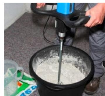
Cada saco de KÖSTER Adhesive SK é misturado com cerca de 5,2 litros de água, utilizando um misturador eléctrico de baixa rotação para uma consistência homogéneo e sem grumos.
