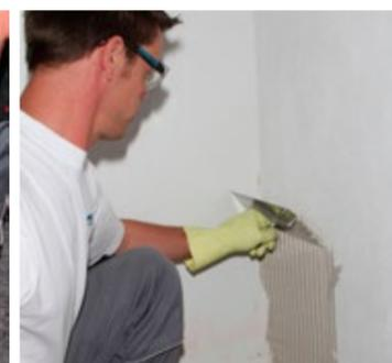
Aplicar o KÖSTER Adhesive SK no substrato com uma talocha dentada de 8 milímetros a cobrir completamente a área da placa. As articulações e juntas das placas devem ser completamente coladas entre si.
