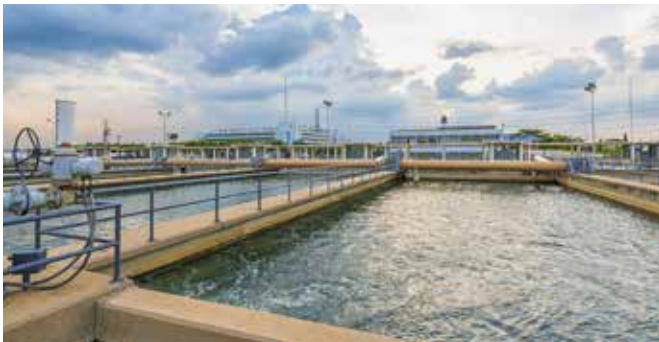
Auffang- und Vorratsbecken
