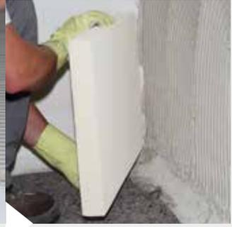
Die KÖSTER Hydrosilikatplatten werden nun auf die Wand gedrückt und dort ausgerichtet. Eine Wasserwaage hilft bei der Ausrichtung.
