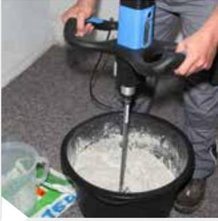
Pro Sack KÖSTER Hydrosilikatkleber SK 5,2 Liter Wasser zugeben und mit einem langsam laufenden Rührwerk zu einer homogenen, klumpenfreien Masse anrühren.
