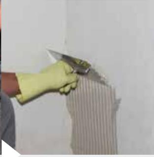
Der KÖSTER Hydrosilikatkleber SK ist anschließend mit einem Zahnschachtel Schritt für Schritt vollflächig auf den Untergrund aufzutragen.
