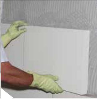
Nach vollständigem Anbringen der KÖSTER Hydrosilikatplatten wird die Oberfläche ggfs. flächenbündig eingeebnet.
