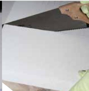
Die Platten sind mit einer handelsüblichen Säge passend zuzuschneiden.
