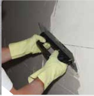
Anschließend wird die gesamte Fläche mit KÖSTER Hydrosilikatkleber SK in einer maximalen Schichtdicke von 2 mm abgespachtelt und geglättet. In die Spachtellage ist mittig das KÖSTER Armierungsgewebe einzubetten.
