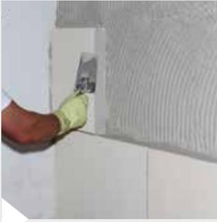
Die Randbereiche der Platten werden mit einer umlaufenden Randwulst aus KÖSTER Hydrosilikatkleber SK versehen, um die Fugenbereiche zwischen den Platten vollständig zu verschließen.
