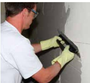
*Após a instalação das placas, a superfície deve ser lixada. Subsequentemente, a área inteira é rebocada com uma camada de adesivo KÖSTER Adhesive SK, com uma espessura máxima de*
