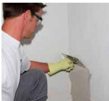
Aplicar o KÖSTER Adhesive SK no substrato com uma talocha dentada de 8 milímetros a cobrir completamente a área da placa. As articulações e juntas das placas devem ser completamente coladas entre si.
